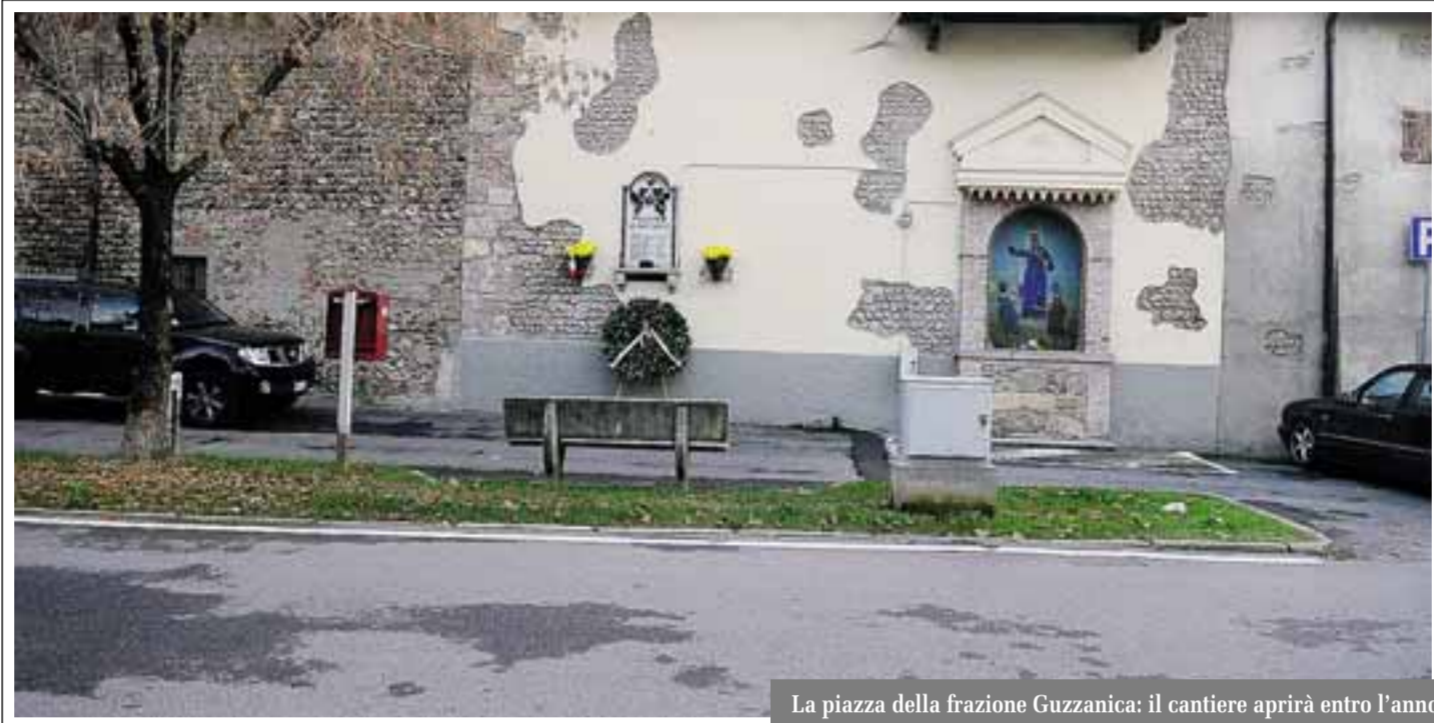
La piazza della frazione Guzzanica: il cantiere aprirà entro l'anno
